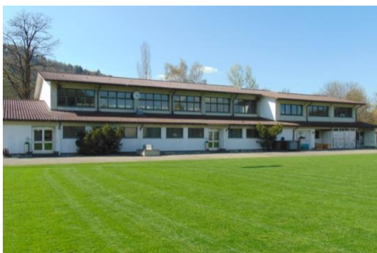
Turnhalle Thalgut mit Anbau Werkräume (rechts)
