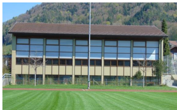
Turnhalle Gurnigel mit Lehrschwimmbecken im Untergeschoss
